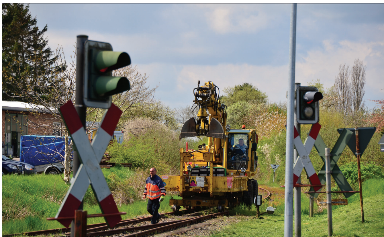
Ein Spezialbagger mit Anhänger (hier am Übergang Bahnhofstraße in Schönberg) bringt die ersten Schwellen zum Schönberger Bahnhof. Dort muss die Weiche Nummer 3 erneuert werden. Fotos Wilhelmy
